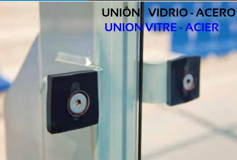
Los puntos de contacto entre las planchas de vidrio templado y el material metálico, son los lugares más delicados para la pista de pádel; por ello se ha puesto especial cuidado al diseñar y elegir el material empleado.
